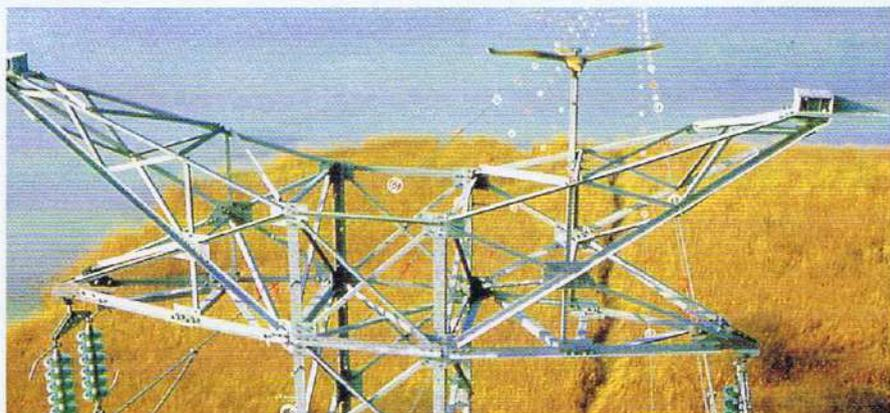
Dispositif anti-percussion sur ligne haute tension.
