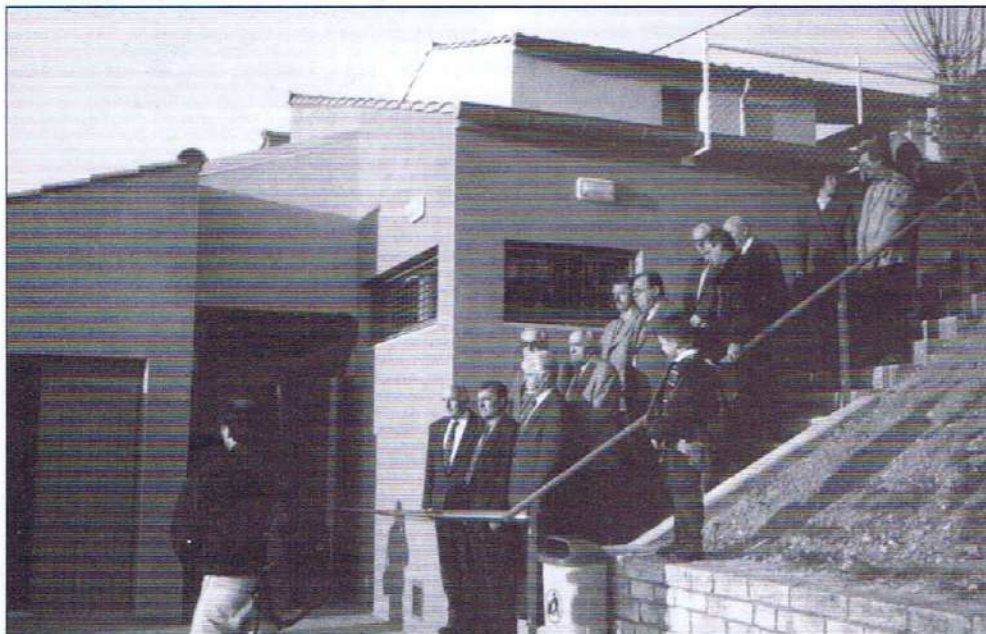
VESTIAIRES "PIERRE PASCAL". FINANCÉS AVEC L'AIDE DE LA RÉGION ET, IN EXTREMIS, PAR LE DÉPARTEMENT, SUR INTERVENTION EXPRESSE DE M. PATRICK MALAVIEILLE.
