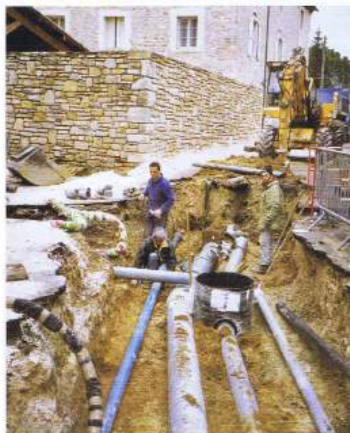
Mise en discrétion des réseaux rue des Glycines
