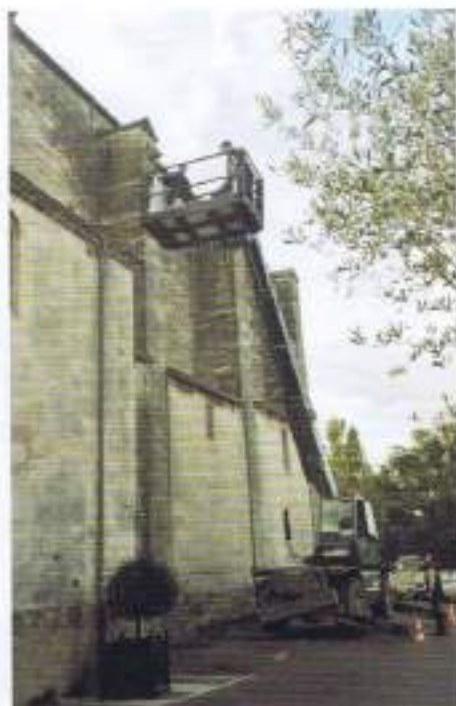
Révision de la toiture de l'église avec le matériel de la Ribaute.
