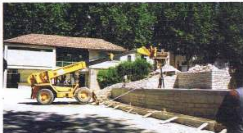
En cours de réalisation
