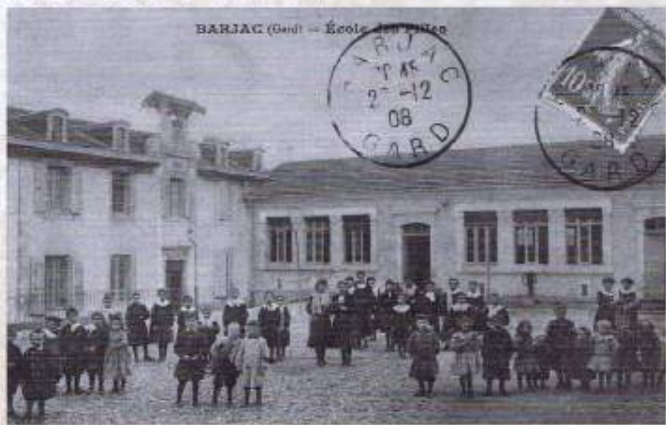
L'école publique des filles après sa construction en 1906
