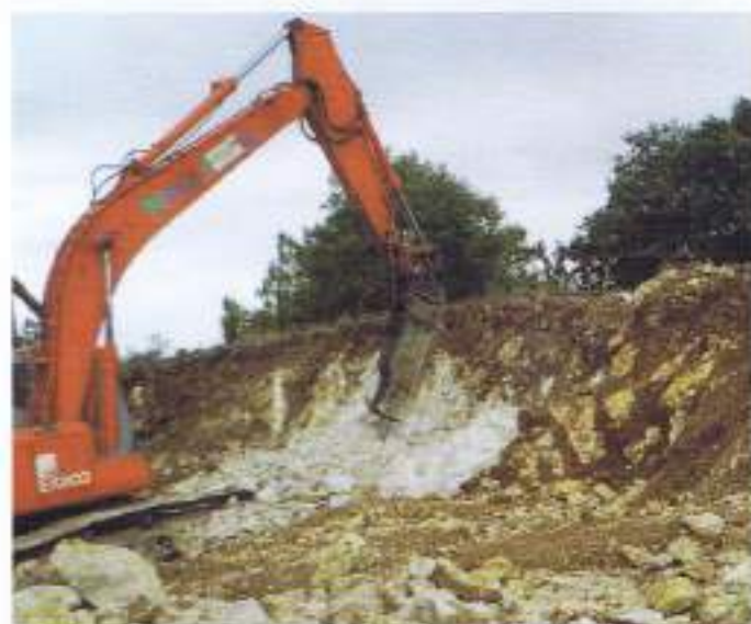
Préparation du terrain pour construction du nouveau réservoir
