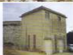
Réservoir existant de 750 m3 maintenu
