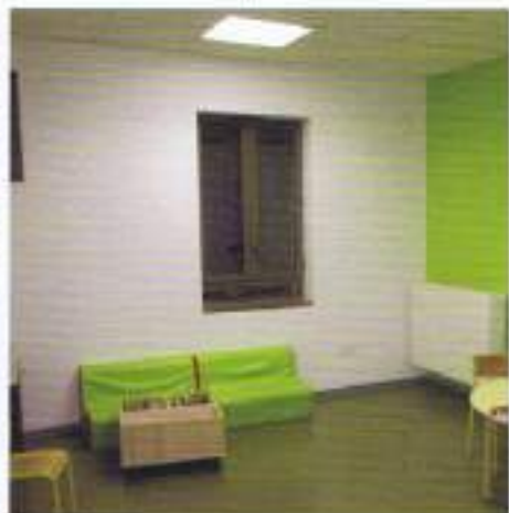
Le centre aéré après travaux
