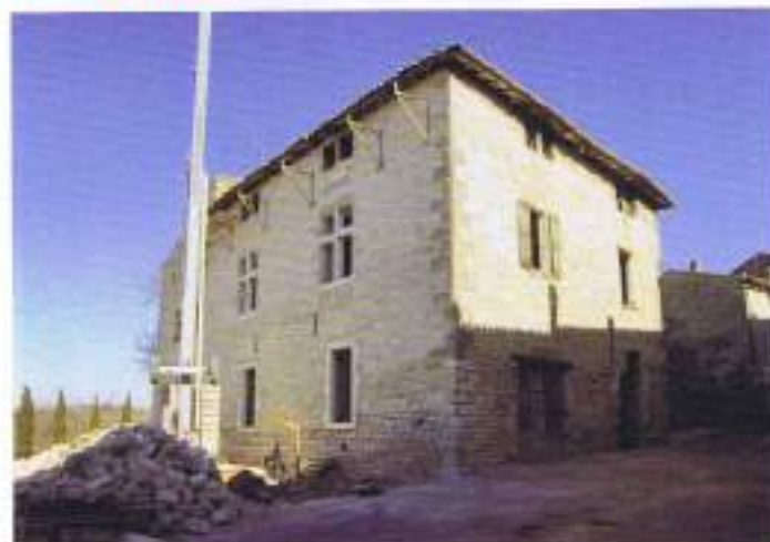
Un bel exemple de rénovation
