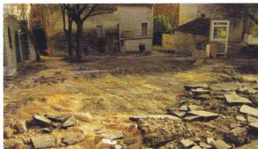
Place de la Liberté en chantier
