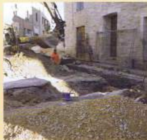
Réhabilitation réseau assainissement Place de la Calade
