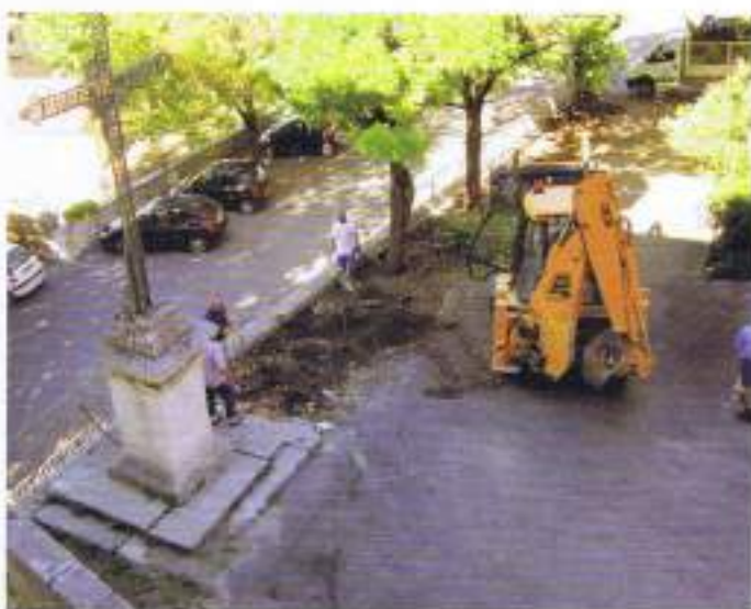
Montée du château arrachage de la haie
