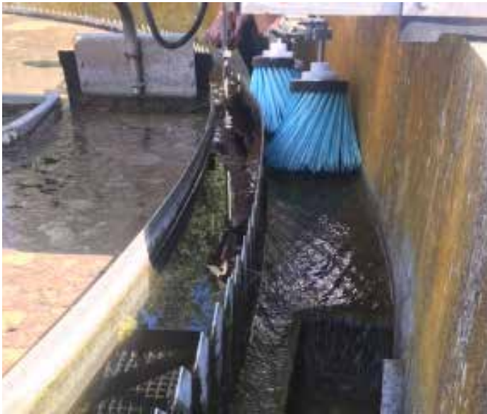
Les brosses du nouveau robot de nettoyage de la station qui permet l'économie d'utilisation de plus de 500 litres de chlore par an !
