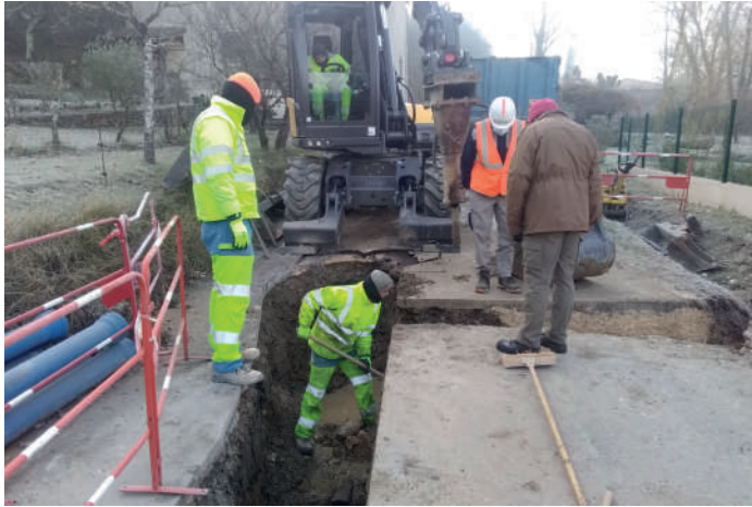
Réunion travaux salavas
